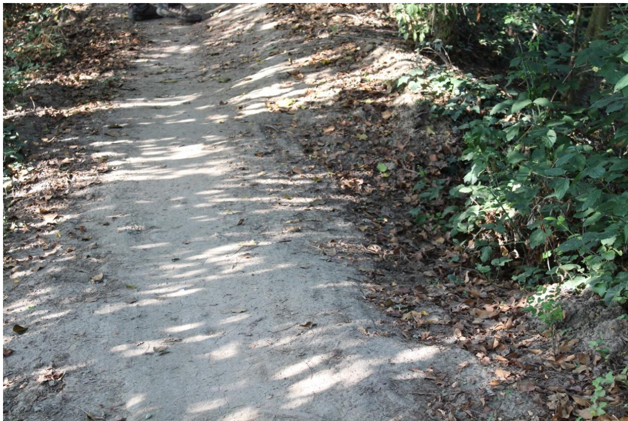
Figura 17 - Avvallamento del fondo lungo il tratto B
