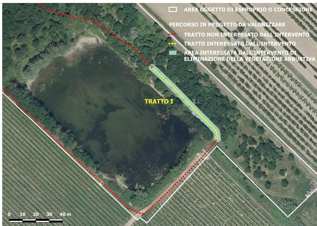
Figura 21 - Interventi sul tratto I : taglio della vegetazione infestante.
