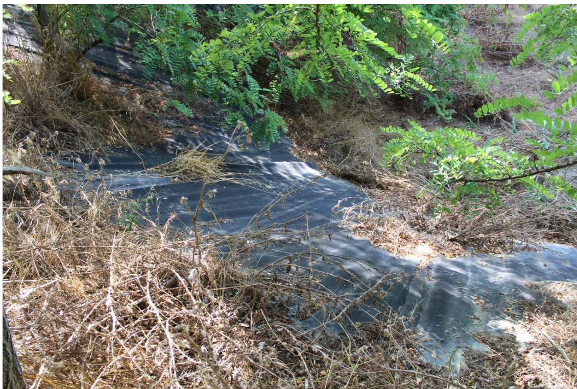
Figura 10 - Telo di rivestimento impermeabile in vecchia vasca per il letame
