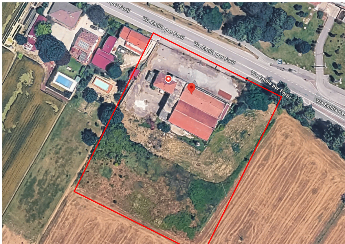
Inquadramento aereo del fabbricato oggetto di intervento
