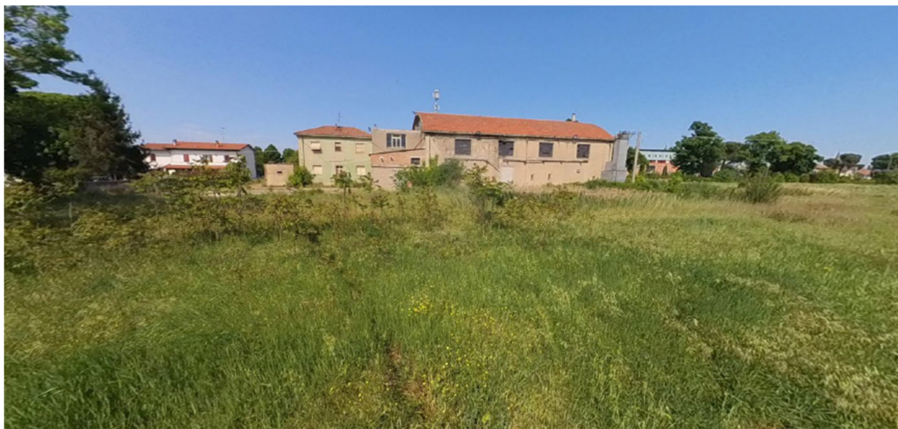
FOTO 03 - VISTA DAL TERRENO AGRICOLO (SUD)
