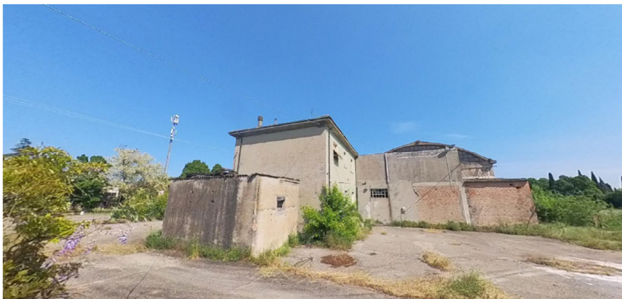
FOTO 04 – VISTA DAL PIAZZALE INTERNO (OVEST)
