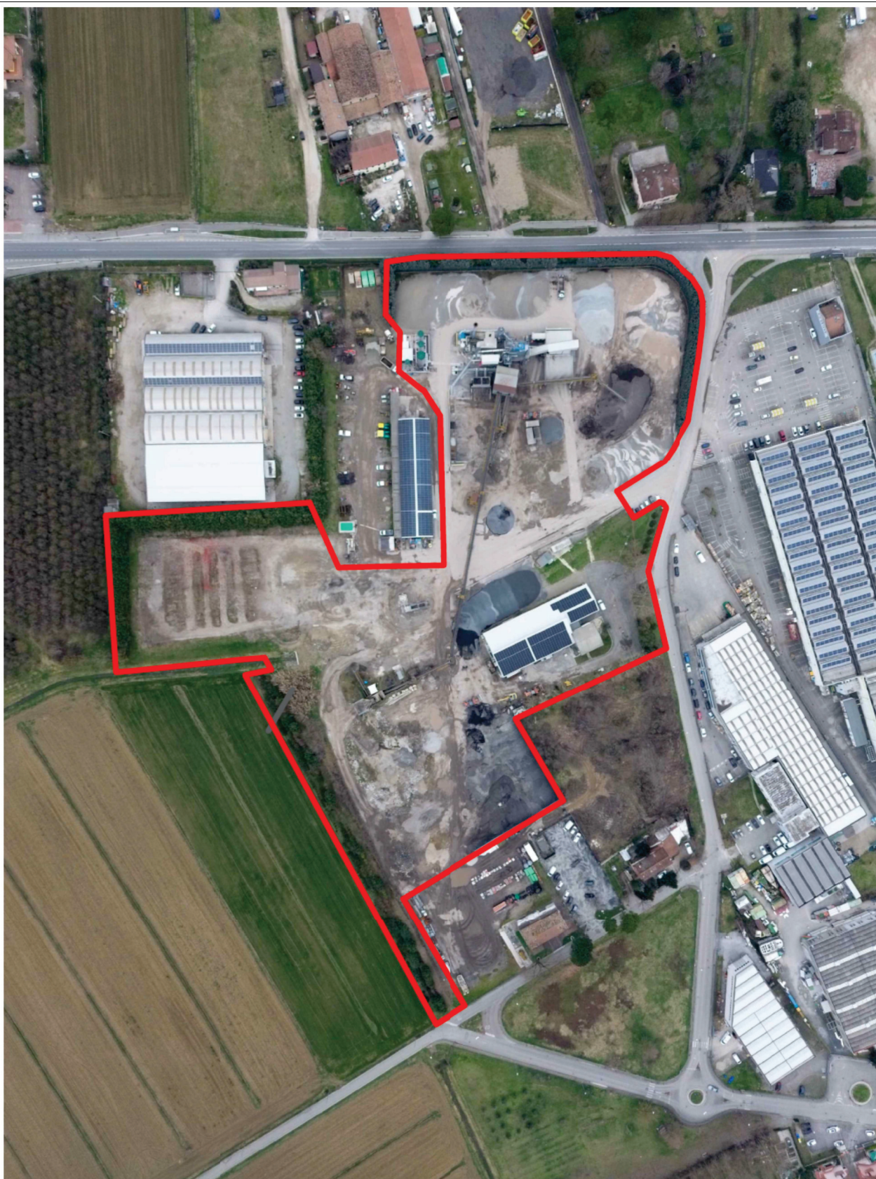
Figura 2: Vista aerea stabilimento Romagnola Conglomerati Srl di Forlimpopoli (FC) e Bertinoro (FC)
