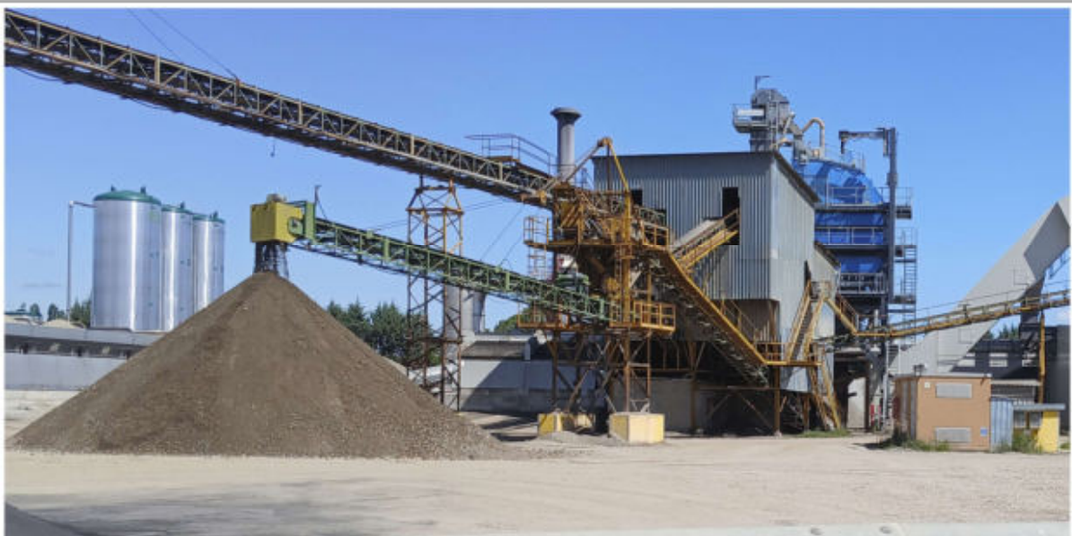
Figura 11: Impianti e macchinari rialzati – stato di fatto
