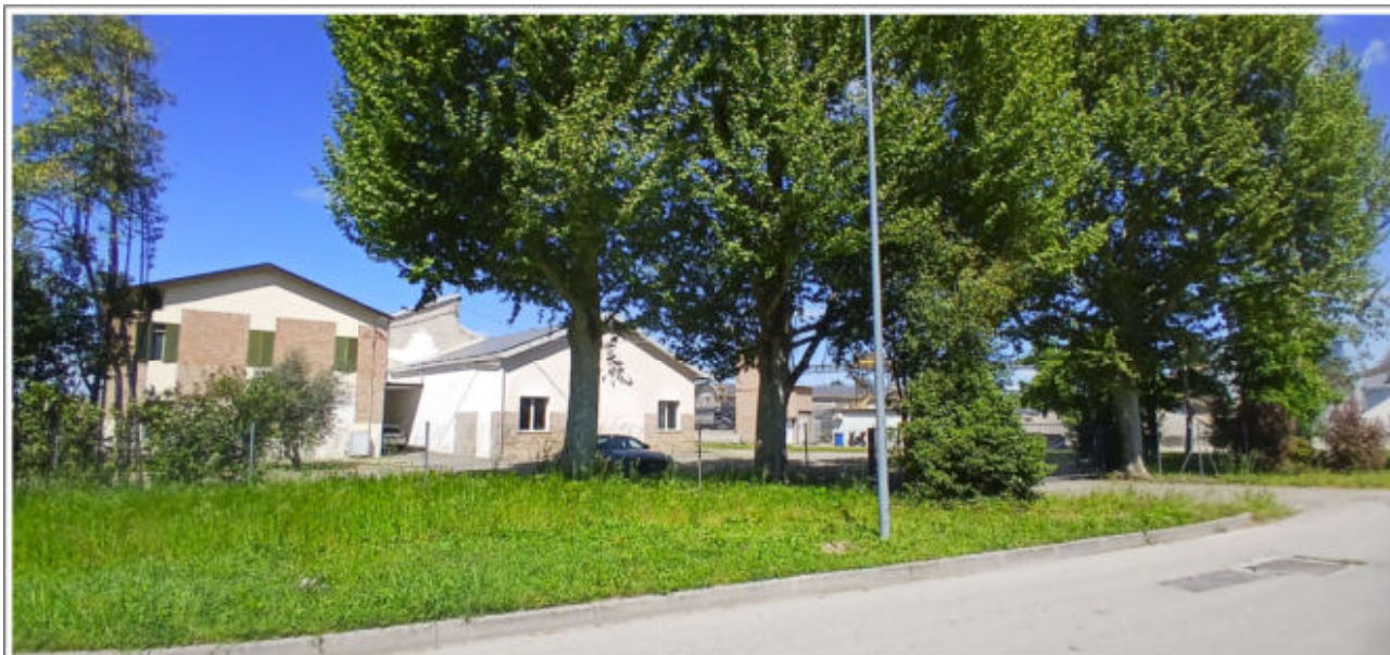
Figura 6: Area di stabilimento interessata dall'evento alluvionale
