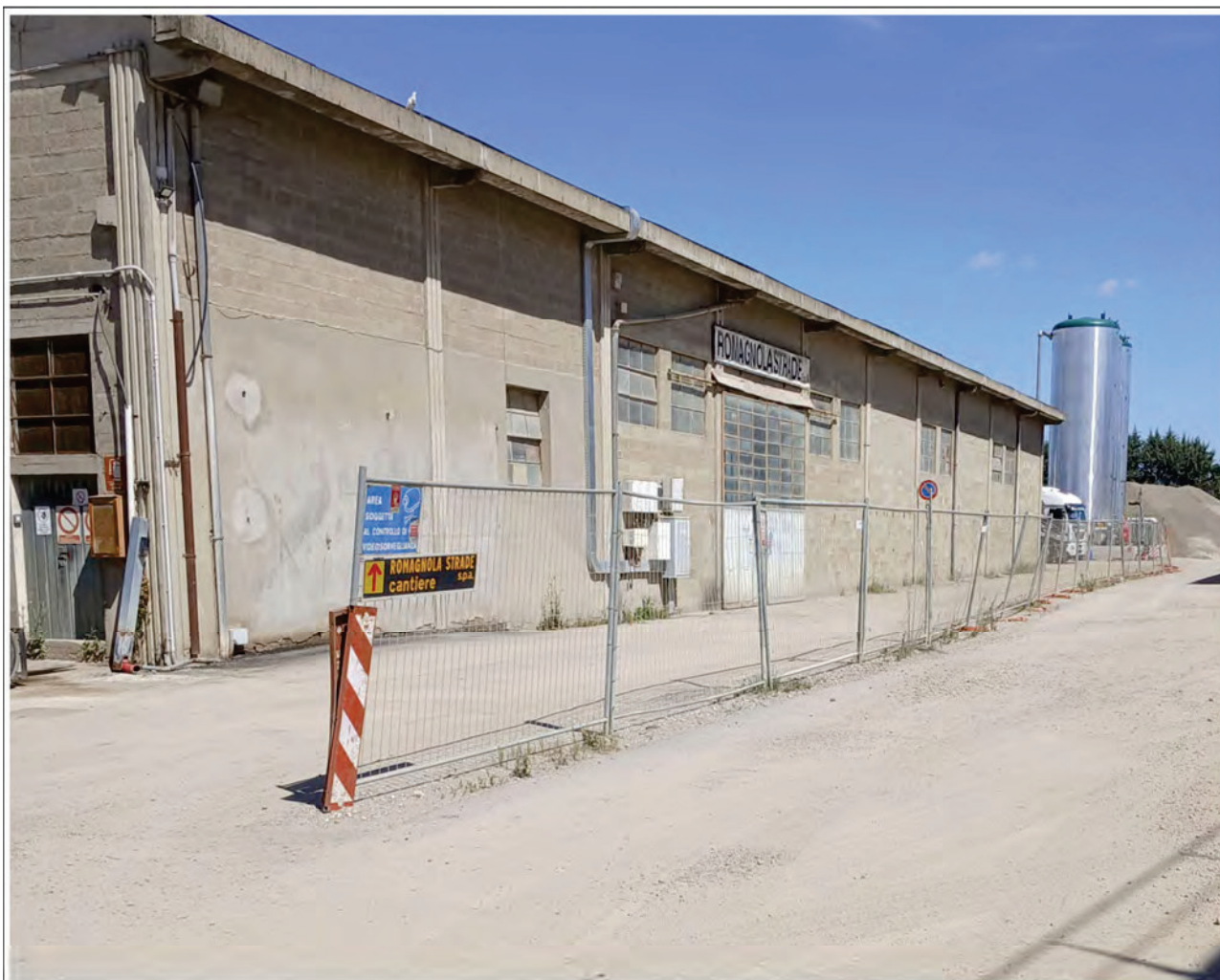
Figura 13: Vista del fabbricato officina dal punto di accesso all'area di Romagnola Strade
