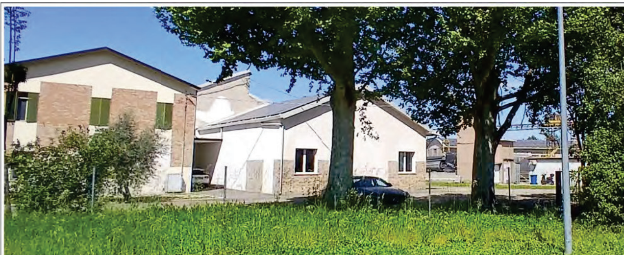
Figura 15: Palazzina uffici (sulla destra dell'immagine vista della portineria/pesa)
