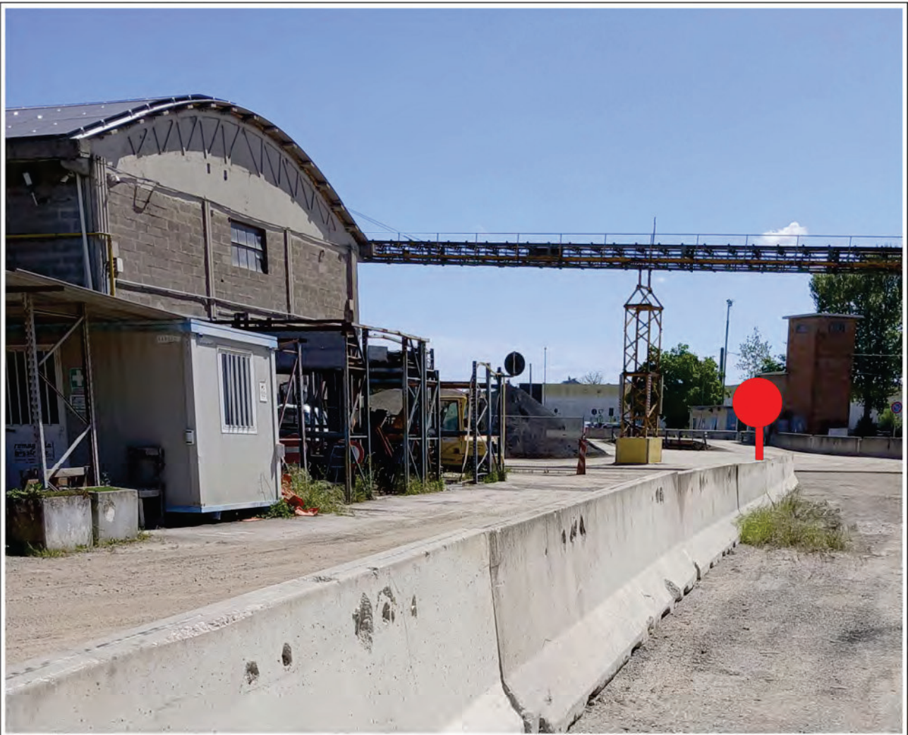
Figura 12: Punto di ingresso e uscita dei mezzi dall'area di Romagnola Strade con nuovo cartello STOP
