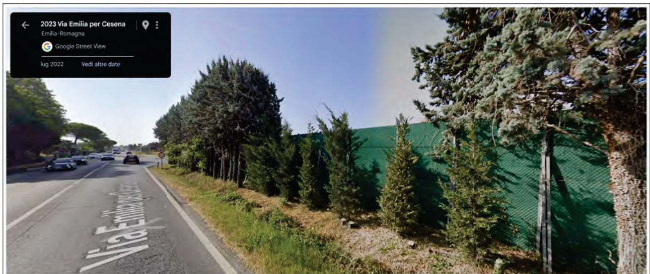
Figura 39: Vista particolareggiata della barriere fisiche dalla SS09 Via Emilia
