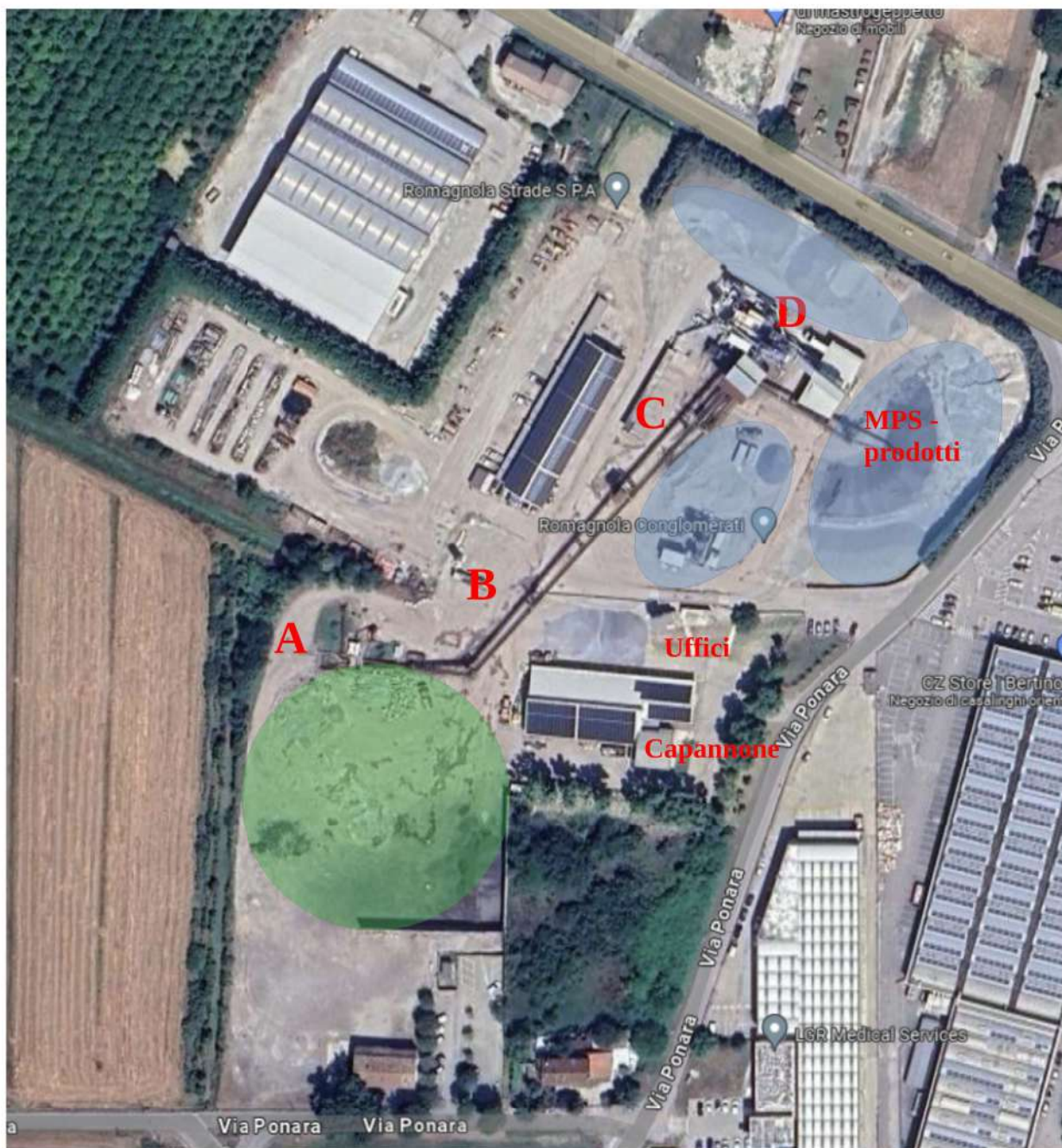
Figura 1: Impianto di frantumazione-vagliatura e di essiccazione-mescolatura
